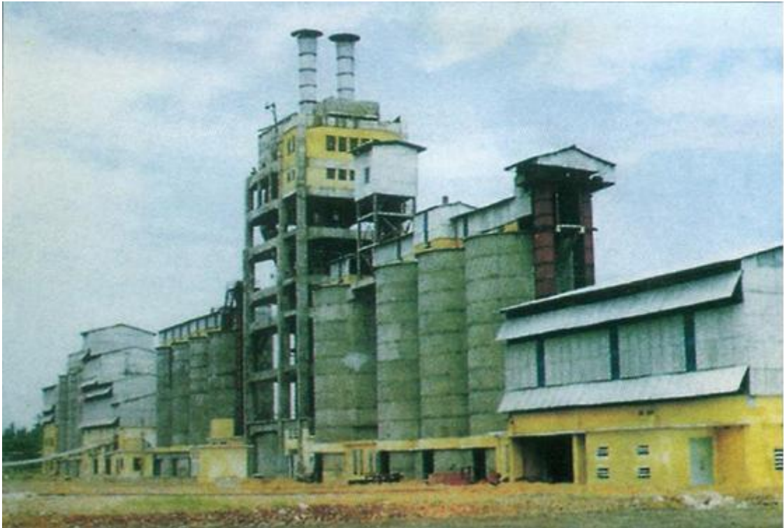
Nhà máy xi măng Lưu Xá – Thái Nguyên công suất 60.000 tấn/năm
