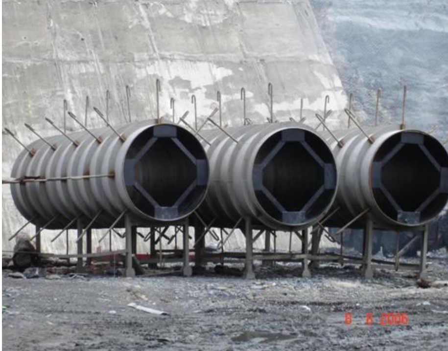
Đường ống áp lực có kích thước lớn (đường kính đến 6m), chịu áp lực cao dùng cho các nhà máy thủy điện
