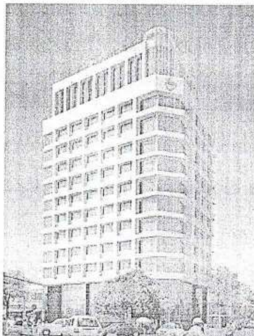
Hình 9 : Tòa nhà TMS|BUILDING
