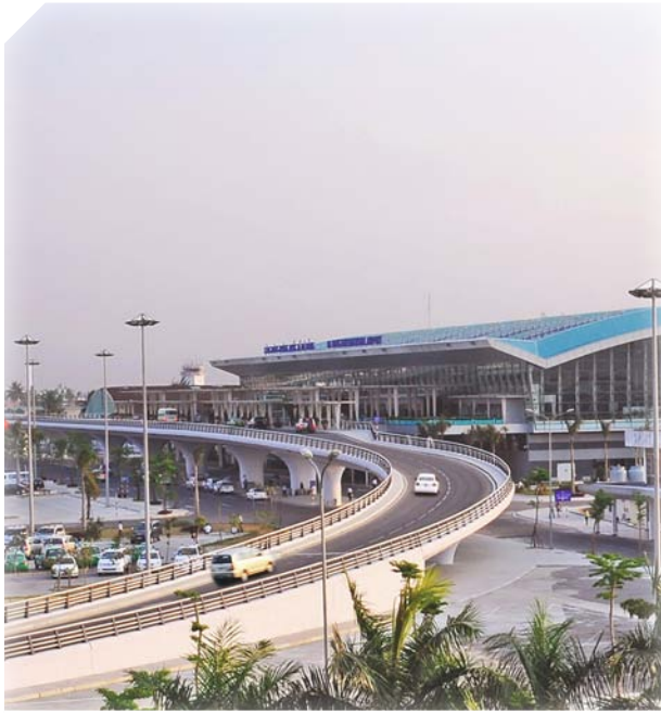
Cảng hàng không Quốc tế Đà Nẵng, một trong những công trình trọng điểm chào đón APEC 2017 tại TP. Đà Nẵng
