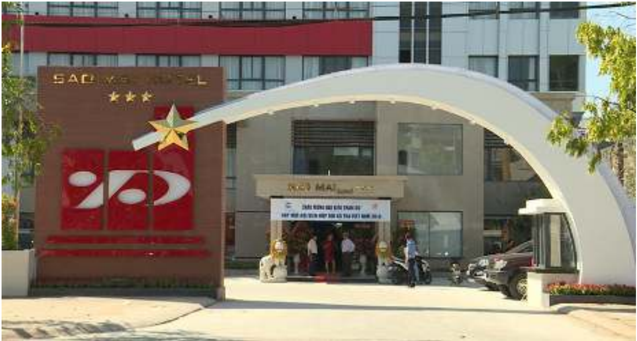
Khách sạn Sông Trà (tọa lạc tại số 178 Nguyễn Huệ- Phường 2- TP Cao Lãnh ) được cải tạo và đổi tên thành Khách sạn Sao Mai
