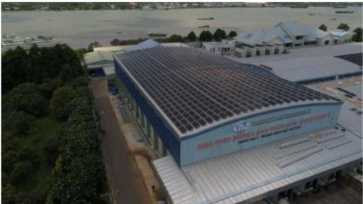
Những tấm pin năng lượng mặt trời đã được lắp đặt tại Nhà máy đông lạnh thủy sản
