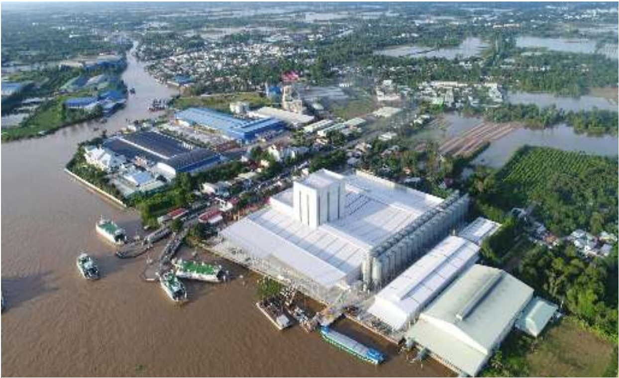
Toàn cảnh các dự án (Nhà máy Đông lạnh thủy sản IDI, Nhà máy CB Phụ phẩm Trisedco, Nhà máy tinh luyện dầu cá AFO, Nhà máy CB NMTA Sao Mai Super Feed) tại Cụm Công nghiệp Vàm Cống của Tập Đoàn Sao Mai
