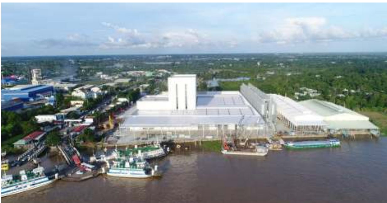
Toàn cảnh Nhà máy chế biến thức ăn thủy sản
