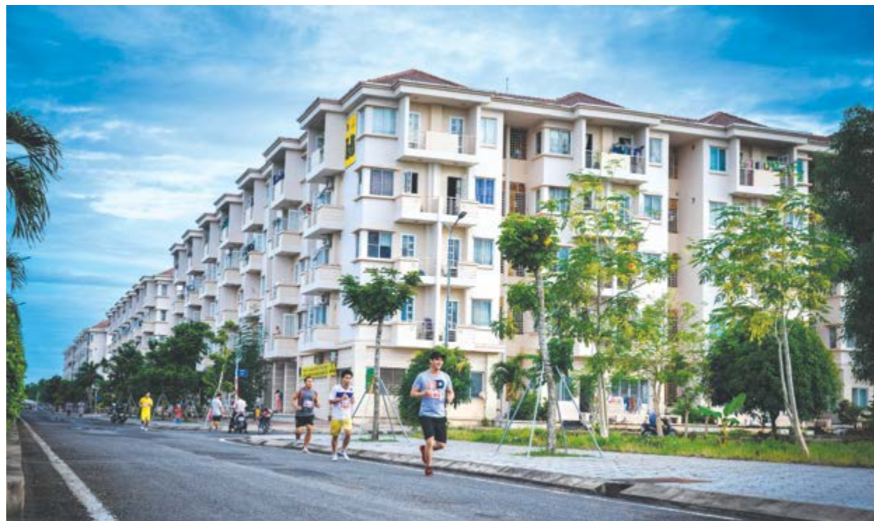
Khu nhà ở của CBCNV khu Khí - Điện - Đạm Cà Mau
