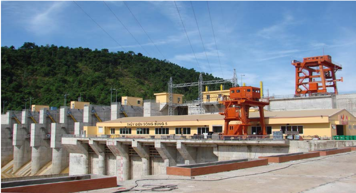
CÔNG TRÌNH THỦY ĐIỆN SÔNG BUNG 5 (Chính thức hòa lưới điện quốc gia tháng 7/2012)
