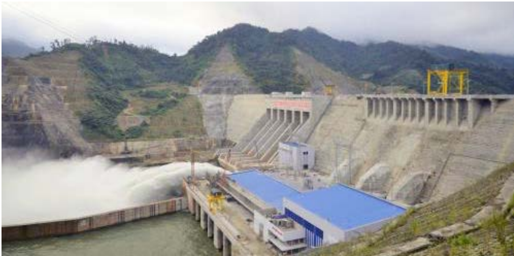
Thủy điện Lai Châu (khánh thành ngày 20/12/2016)
