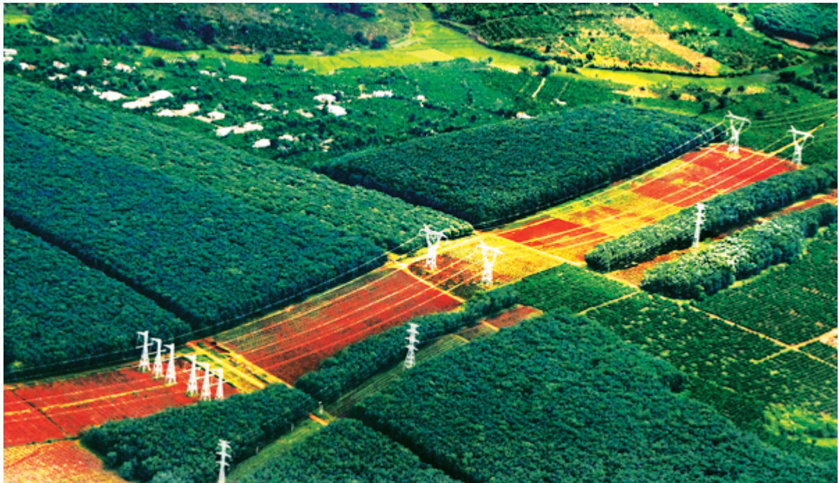
Đường dây 500kV Sơn La - Hòa Bình - Nho Quan
