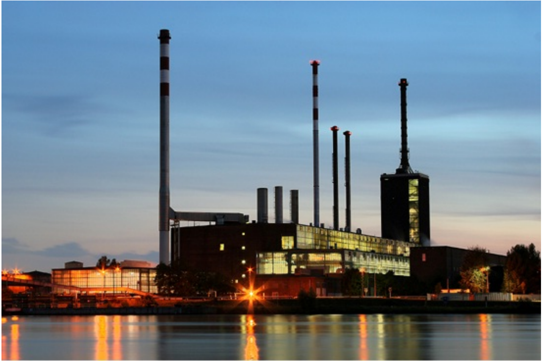
Nhà máy nhiệt điện Thái Bình 2
