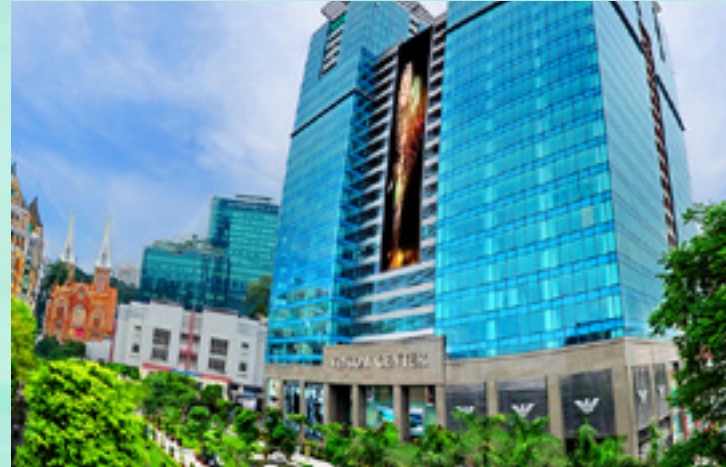
Vincom Center B Hạng mục: Cửa đi, Cầu thang, Ốp vách, Ván sàn gỗ solid, ván sàn KTC và ván Decking bể bơi trong nhà, ngoài trời
