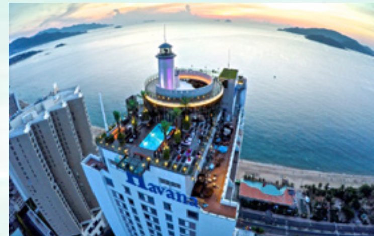
Khách sạn Havana Nha Trang Hạng mục: Cung cấp lắp đặt Cửa các loại, đồ Fitout và Ván sàn kỹ thuật cao.
