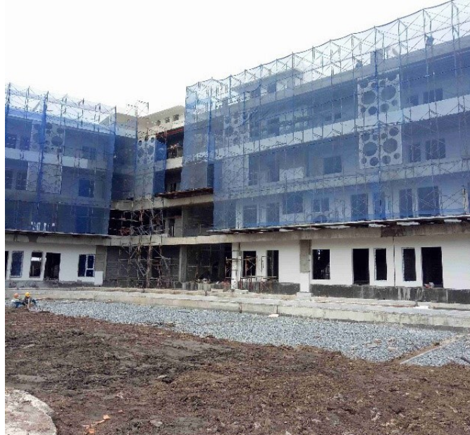
Lakeview 1: Khu nhà 4 tầng đã hoàn thành phần thô, đang thi công hoàn thiện
