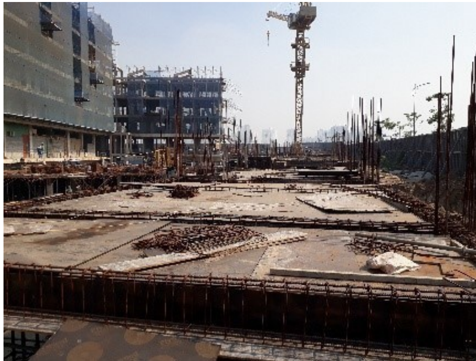
Lakeview 2: Khu 3 và 4 đang thi công lắp dựng cốt sàn tầng hầm
