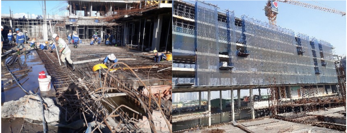
Lakeview 2: Khu 1 và 2 đang thi công xong phần khung thân.
