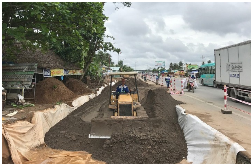
QL60: Đắp cát nền đường trái tuyến
