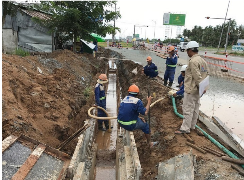
QL60: Thi công rãnh dọc bên phải tuyến
