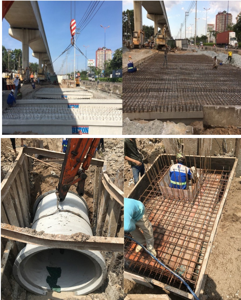
Dự Án Mở Rộng Xa Lộ Hà Nội: Thi công hệ thống thoát nước cống D2000 (đoạn từ đường Alexanderod đến đường Chu Văn An)
