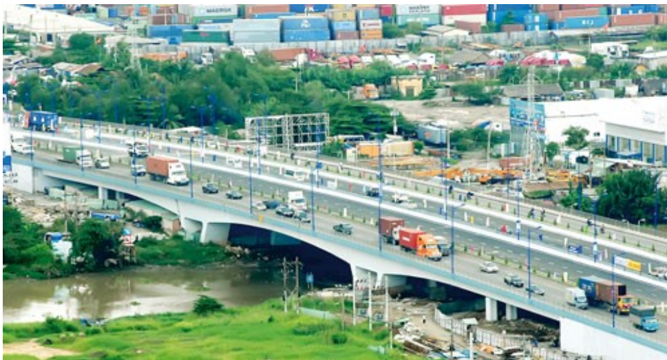
Dự án Cầu Rạch Chiếc nối Quận 2 và Quận 9 – Tp.HCM
