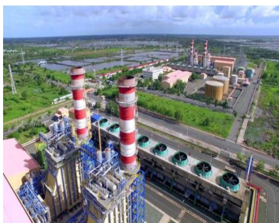
Hình 6: Nhà máy điện Cà Mau 1 & 2
