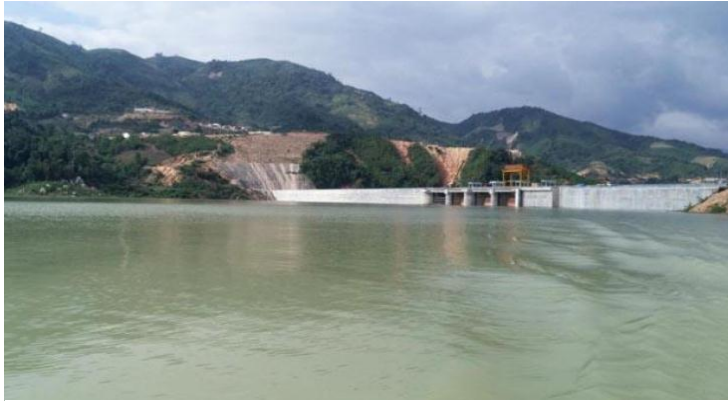
Hình 11: Nhà máy Thủy điện Đakdrinh
