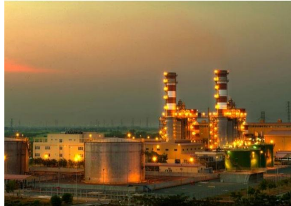
Hình 7: Nhà máy điện Nhơn Trạch 2
