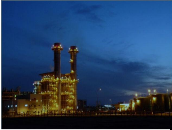
Hình 8: Nhà máy điện Nhơn Trạch 1
